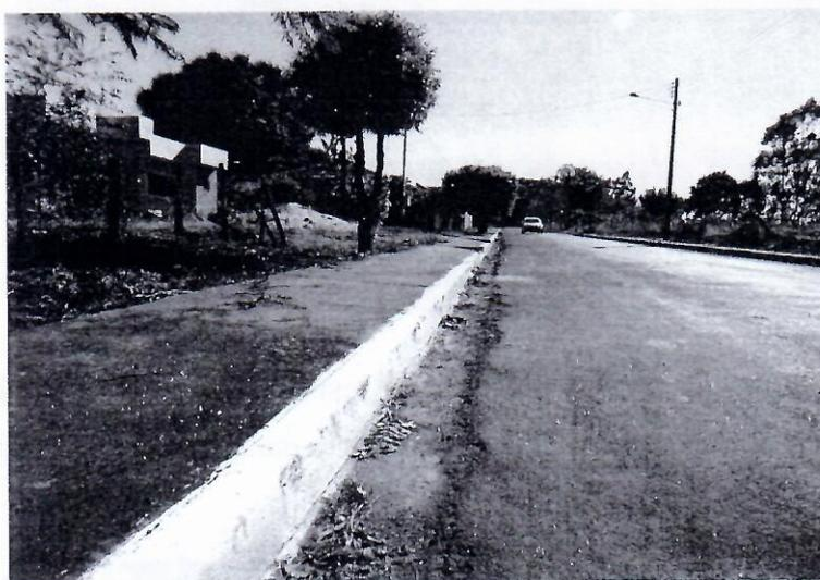
Entretanto, como narrado anteriormente, as caixas de captação de águas plúvias foram instaladas pela Prefeitura, e não houve o nivelamento com o passeio ocasionando obstrução para o trânsito de pedestres, e nas ruas que ainda não foram asfaltadas há inclusive o desalinhamento das caixas de captação com o eixo da pista de rolamento o que ocasiona obstáculo para a livre circulação.
