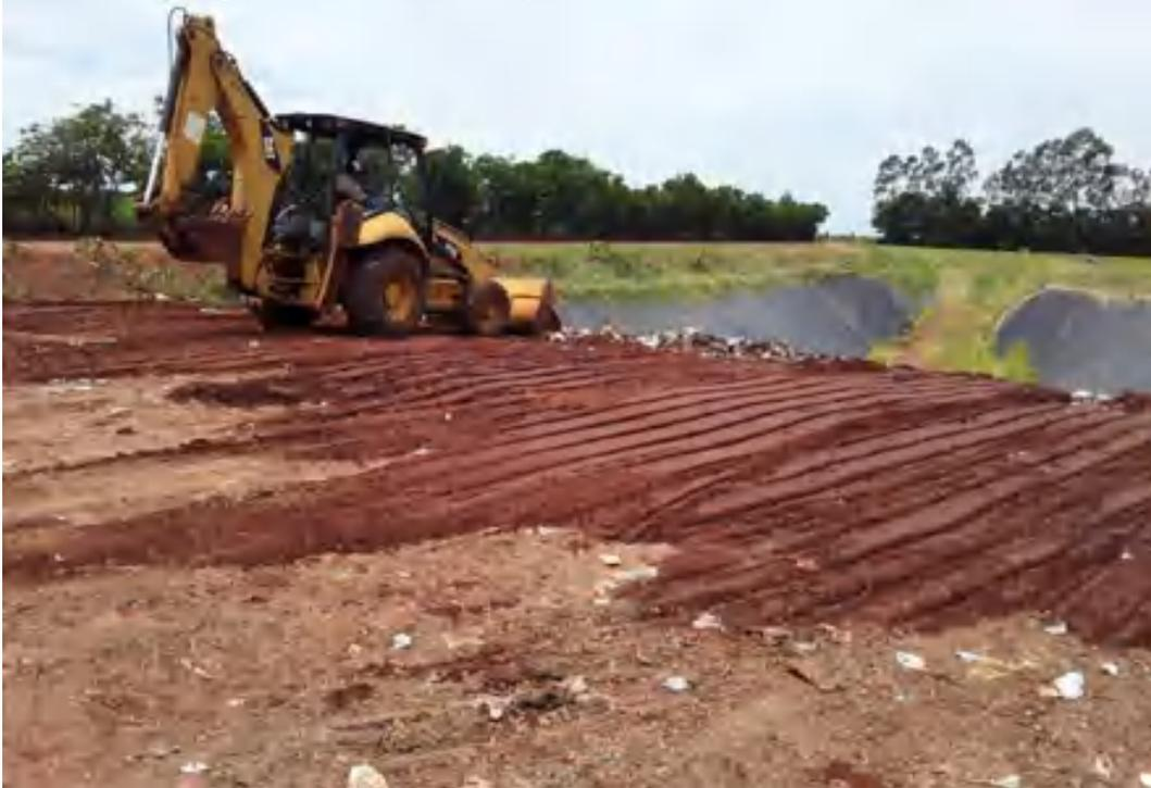
**FOTO 7 - Recobrimento dos resíduos na trincheira impermeabilizada**
